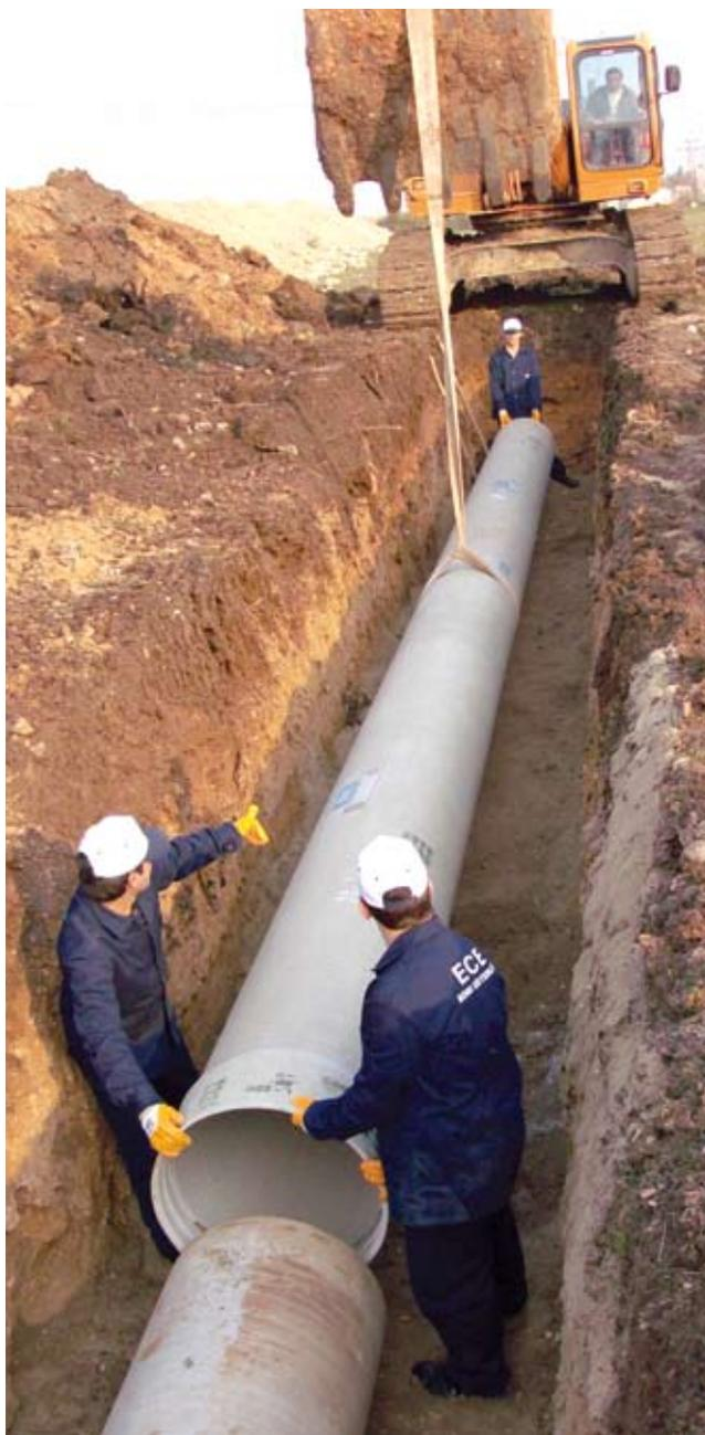
Начальные лимиты отклонения для ПТАС проложенных под землёй; Для труб под давлением для DN ≥ 300 mm %3; Для труб не под давлением для DN ≥ 300 mm %6.
