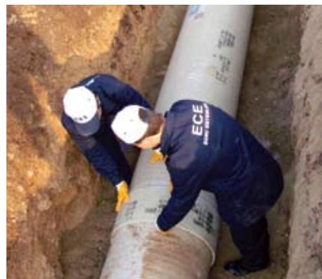
Производится гранулярное заполнение от верхней части трубы до расстояния (h). Это высота (h) мин. 100 макс. 300 мм.
