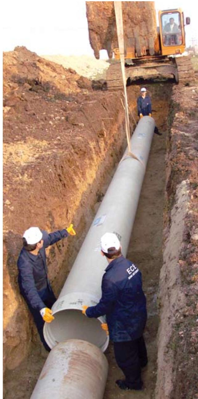
حدود سهم البداية لأنابيب GRP التي تم فرشها تحت الأرض؛ في المواسير المضغوطة  $DN \geq 300\text{mm}$  هي 3 % وفي المواسير الغير مضغوطة  $DN \geq 300\text{mm}$  هي بنسبة 6 %.
